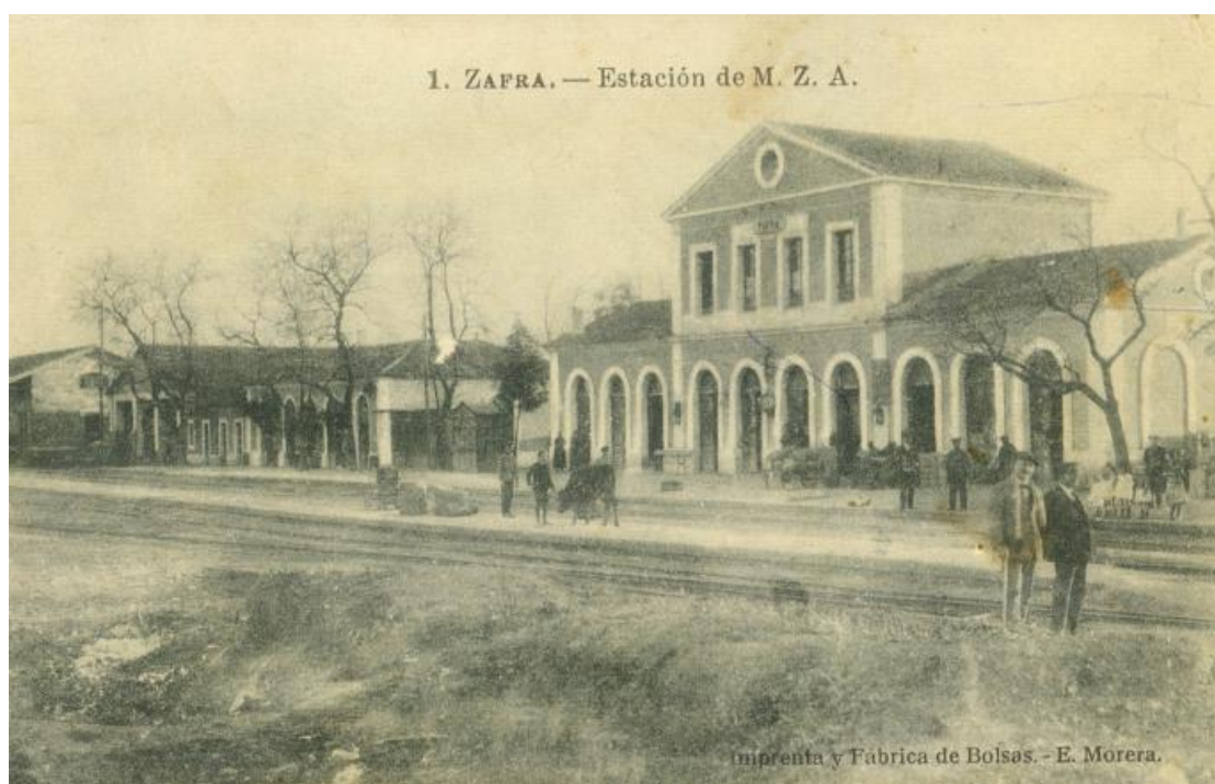
Antigua estación de ferrocarril de Zafra perteneciente a MZA
